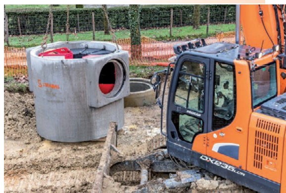
Saint-Barthélemy d'Anjou (49) Décanteur hydrodynamique Vortex DN2000
